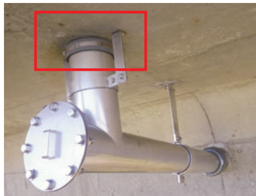
FRP製集水桝とPVC管を RDジョイントφ150を用いて接続
