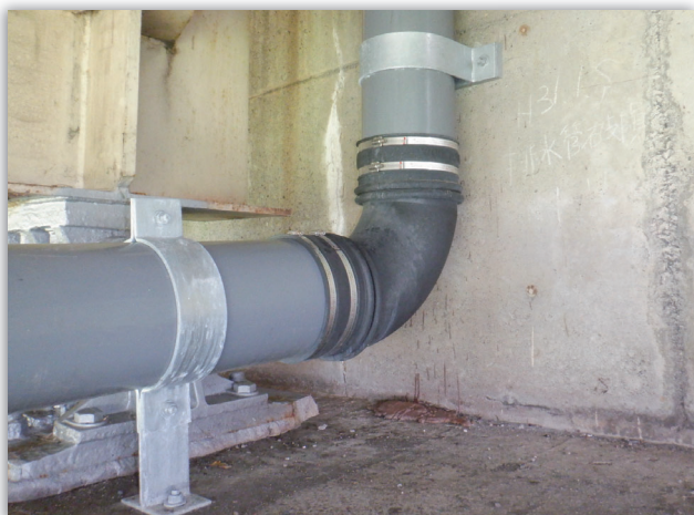
中央自動車道管内橋梁
