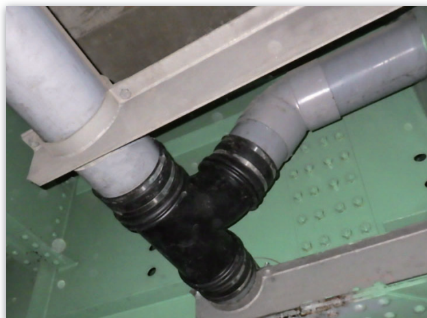
名古屋高速道路管内橋梁
