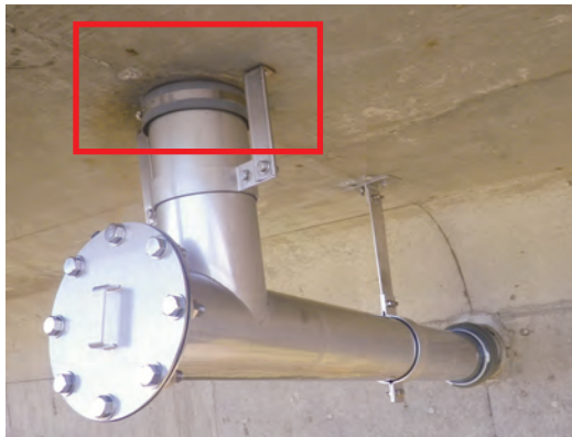
FRP製集水樹とPVC管をRDジョイントφ150を用いて接続
